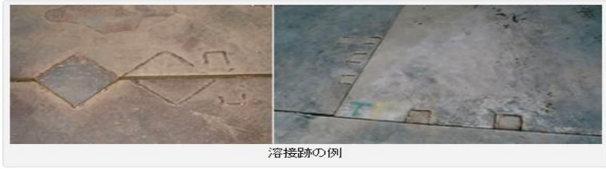
従来の鋼板の溶接による連結 → リンクプレートによる連結
